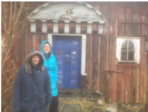
Anne Cathrine og Nina foran låven. Ett av 8 bygg som sårt trenger vedlikehold.
